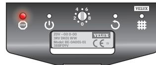
V primeru napak v prezračevalnem sistemu z rekuperacijo sveti rdeča svetlobna dioda.
