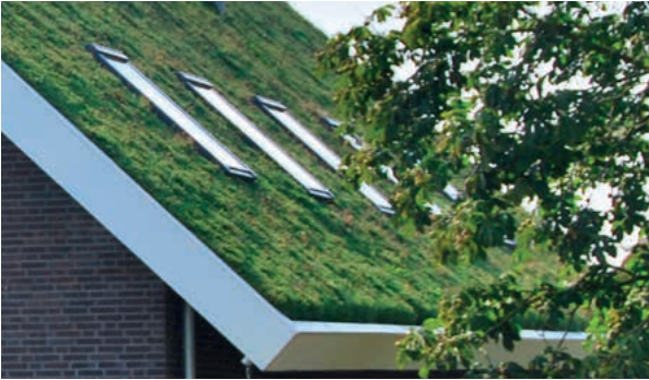
Eksempel på skråtakskonstruksjon med sedum.
