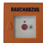
SHEV DIN secondary switch
