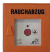
SHEV DIN main release switch
