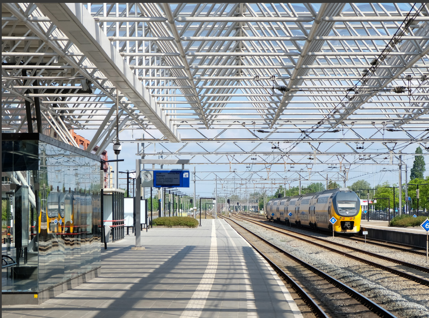
Ci-dessus: Gare ferroviaire de Zaandam aux Pays-Bas, une structure en acier de 8000 m2 avec 489 lanterneaux résistants aux chocs
