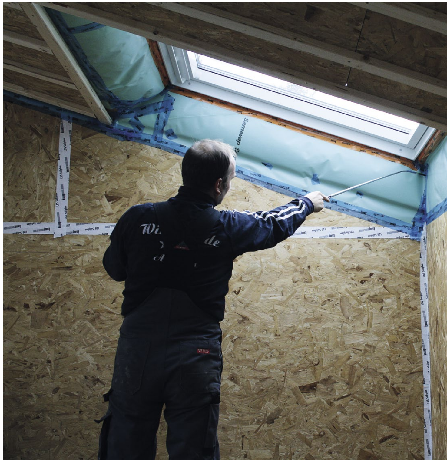
Aufspüren von Leckagen mit einem Luftgeschwindigkeitsmessgerät während der Blower-Door-Messung
