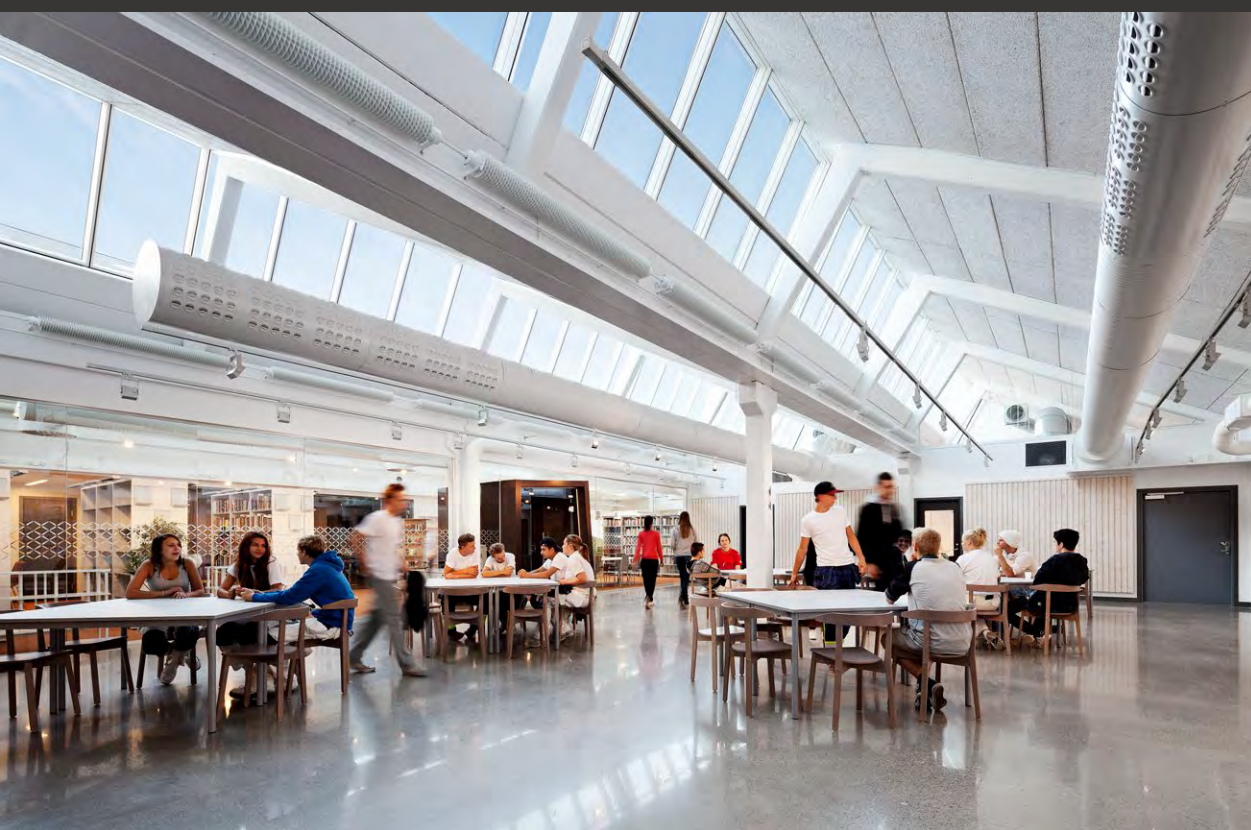
Sågbäcksgymnasiet, Sztokholm, Szwecja. Cztery pasma świetlne szedowe, 104 moduły.
