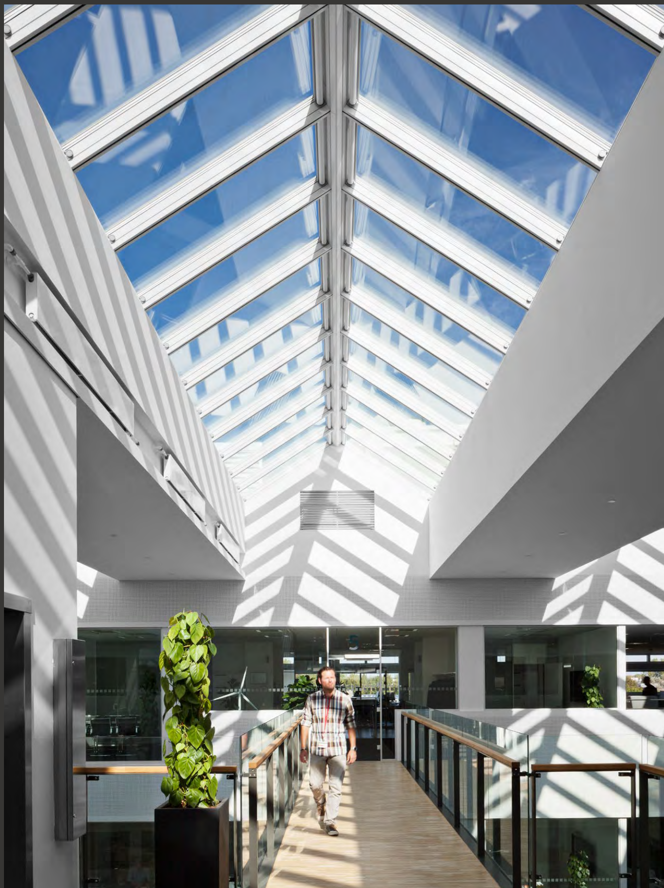
Centrala Siemens, Ballerup, Dania. Jedno pasmo świetlne dwuspadowe Atrium, 228 modułów.
