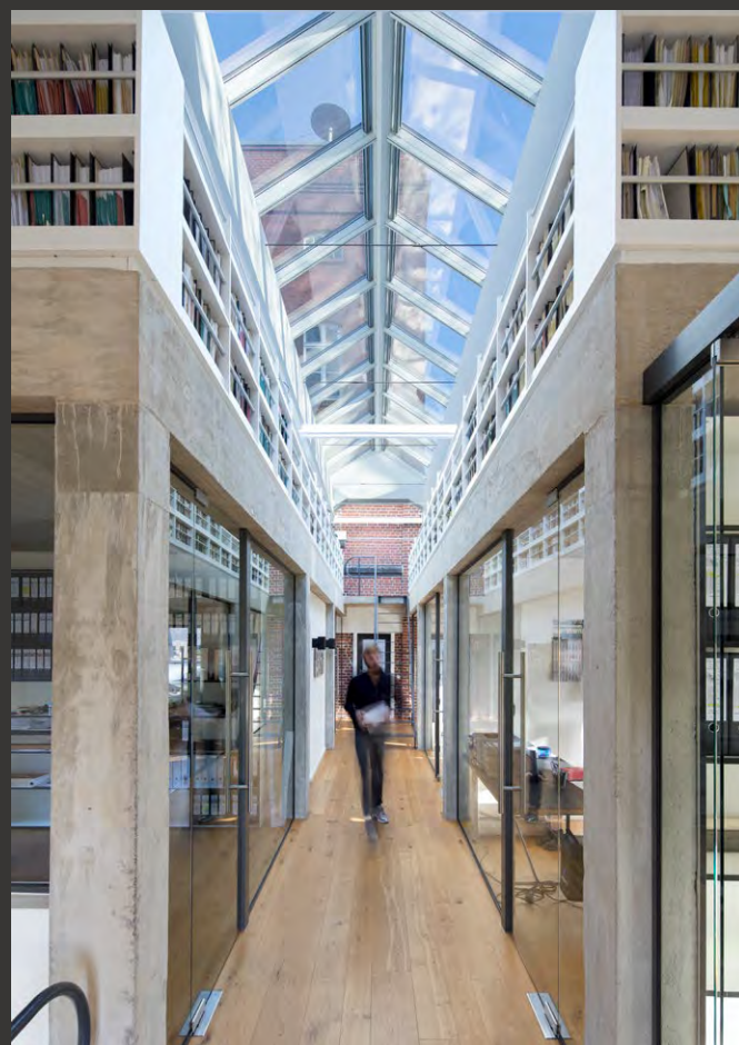
Stara remiza strażacka, Biuro architektoniczne, Leverkusen, Niemcy. Jedno pasmo świetlne dwuspadowe, 22 moduły.
