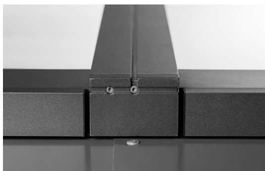
Montaż oblachowania i kołnierza uszczelniającego z przodu doświetlenia dachowego.
