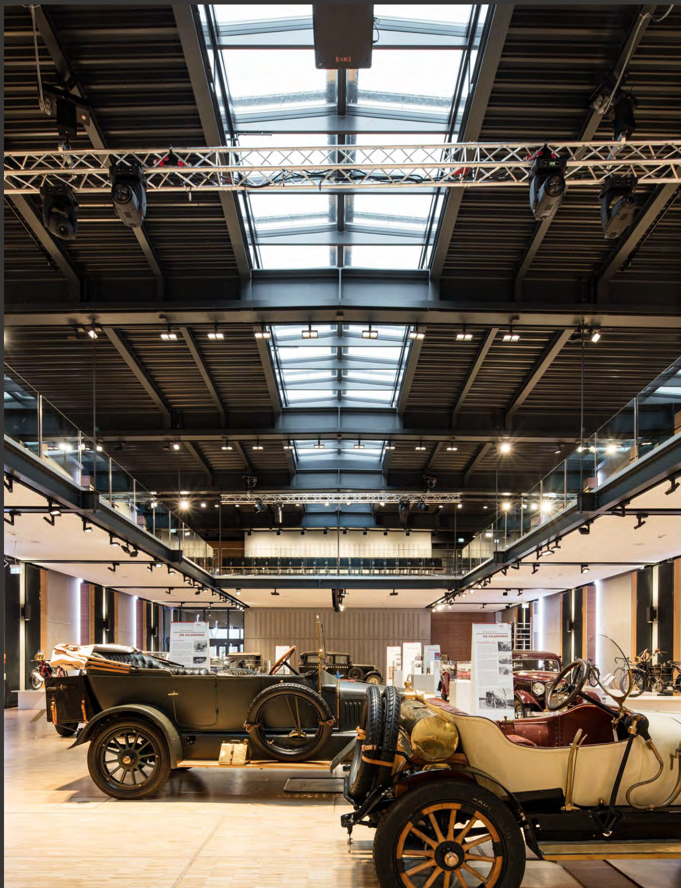
PS.Speicher, muzeum, Einbeck, Niemcy. Pasma świetlne dwuspadowe 5° z belkami, 50 modułów.
