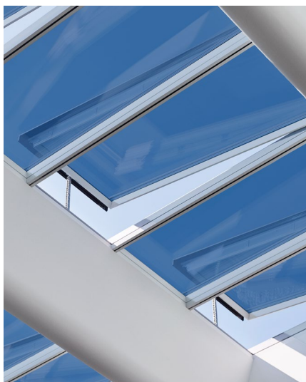
Przeszklenie ze szkłem elektrochromatycznym w stanie pośrednim. Przepuszczalność światła widzialnego 15%
