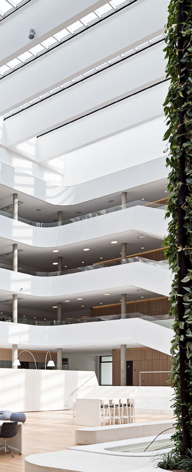
Powyżej: Rozwiązanie Atrium w siedzibie głównej DSV, Hedehusene, Dania
