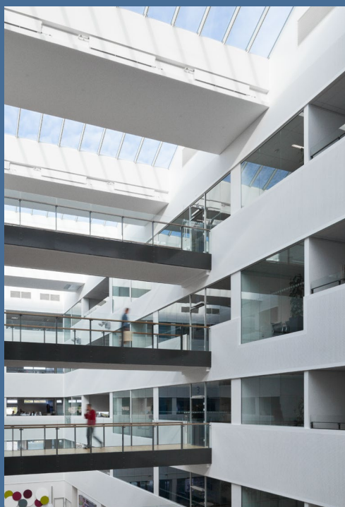
Centrala Siemens, Dania, certyfikat LEED Gold
