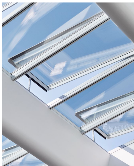
Przeszklenie ze szkłem elektrochromatycznym w stanie jasnym. Przepuszczalność światła widzialnego 57%
