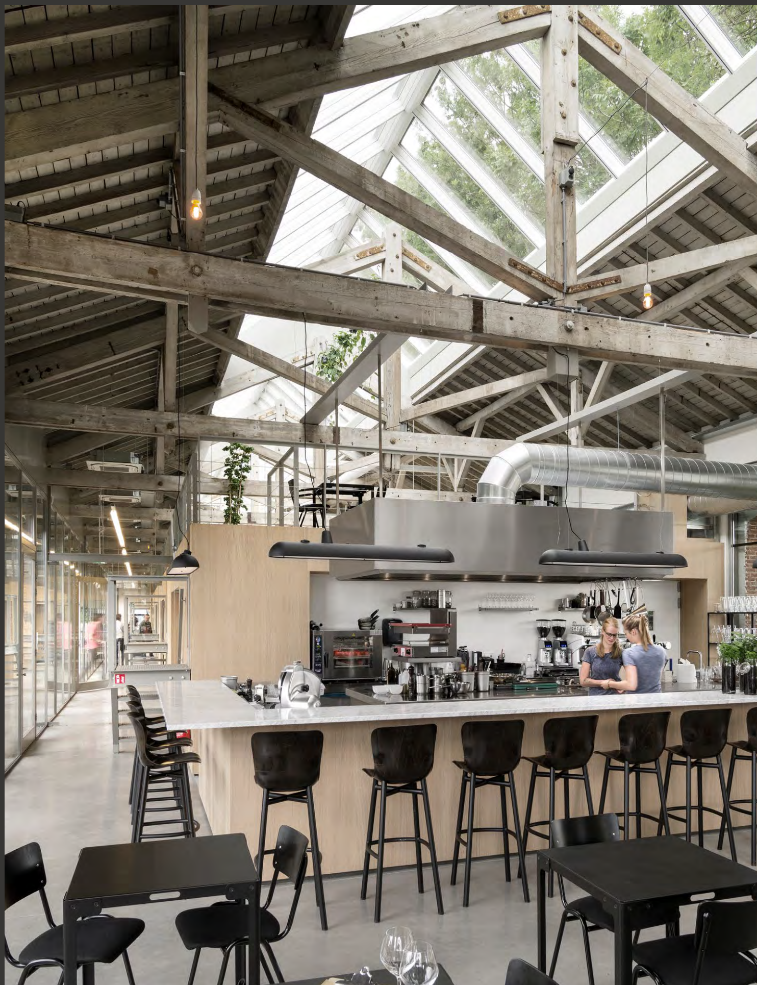
Restauracja De Houtloods (przekształcenie starego magazynu kolejowego), Tilburg, Holandia. Jedno pasmo świetlne dwuspadowe, 124 moduły.
