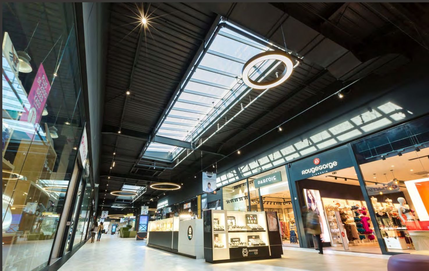
Centrum handlowe Villebon 2, Villebon-sur-Yvette, Francja. Siedem rzędów pasm świetlnych i dziesięć rzędów pasm świetlnych dwuspadowych, 194 moduły.
