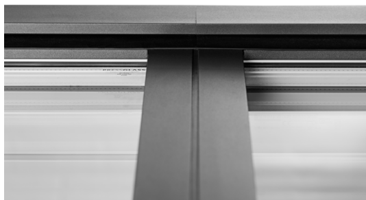
Montaż oblachowania sekcji środkowej i górnej. Pasma świetlne 5-30°.
