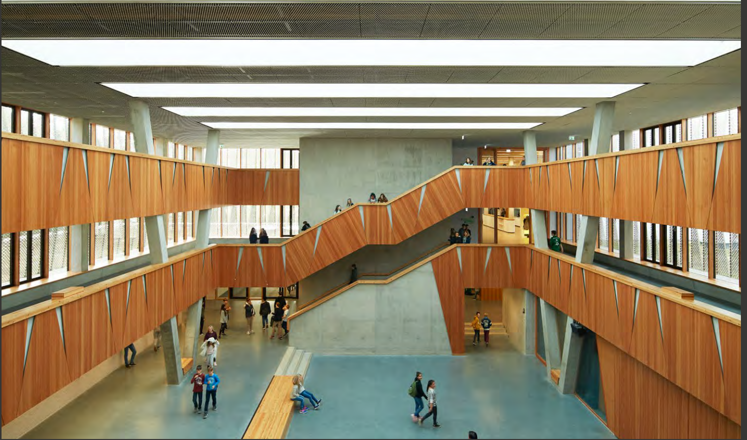
Hessenwaldschule, Weiterstadt, Niemcy. Jedno rozwiązanie Atrium, 84 moduły
