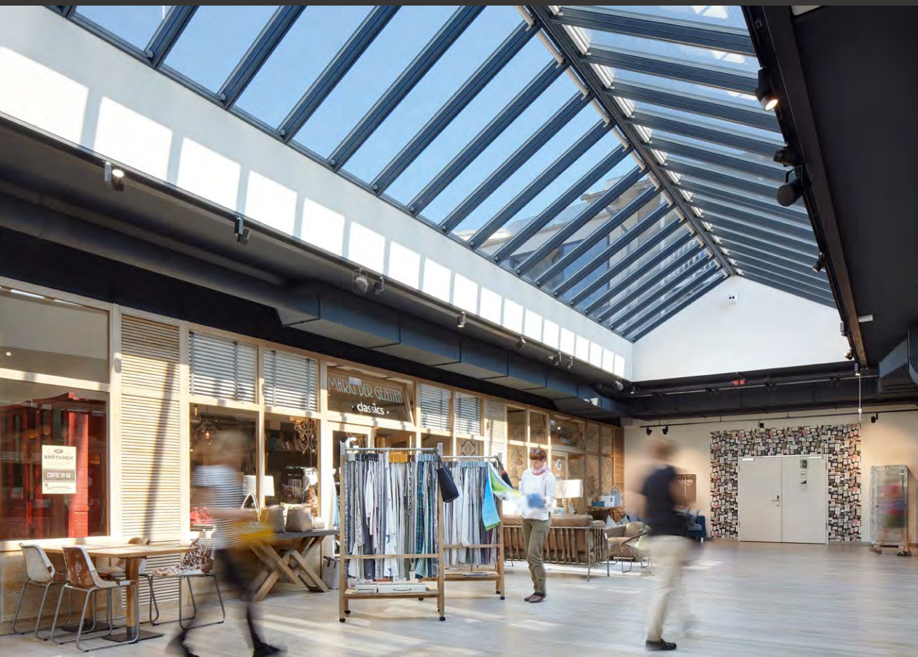
Centrum handlowe Lister Market, wyspa Sylt, Niemcy. Jedno pasmo świetlne dwuspadowe, 64 moduły.
