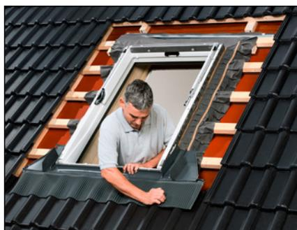
EDW/L: Raccordements et isolation thermique parfaits tout autour de la fenêtre de toit VELUX.
