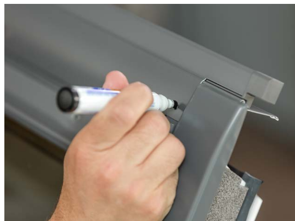
Marquer l'emplacement des trous avec le marqueur.
