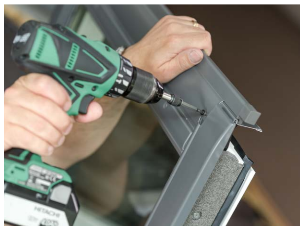
Repositionner le profilé bas et le visser de chaque côté à l'aide des vis 10 mm du sachet D.
