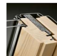
Leseno okno, obdelano z brezbarvnim lakom na vodni osnovi, ki ščiti les pred umazanijo in vlago.
