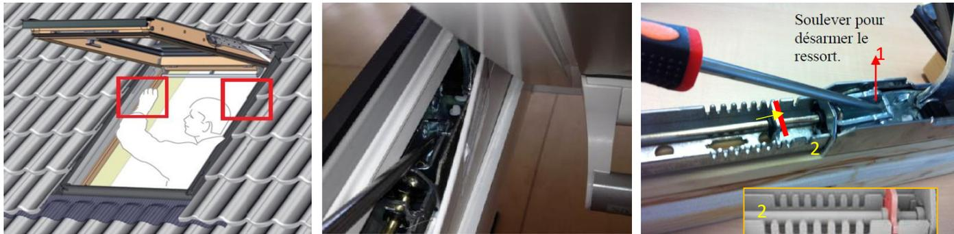
Récemment un autre système de désaccouplage a été mis en production : il faut simplement soulever la pièce 'guillotine' qui verrouille le chariot du bras de projection. Idem pour le poids de l'ouvrant.
