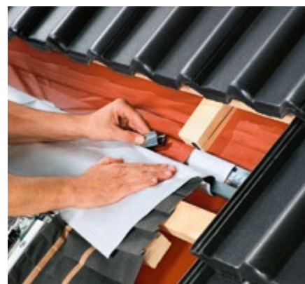
Montaż rynienki do odprowadzenia wody
