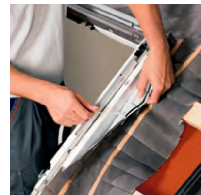
Szybkie i szczelne połączenie BFX z ościeżnicą okna dzięki butylowej warstwie klejącej
