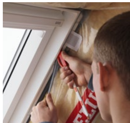
Wokółokienna paroizolacja BBX 0000
