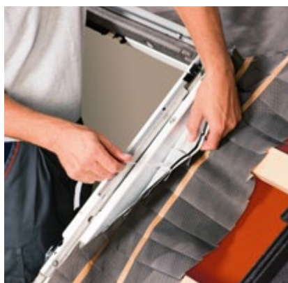
Szybkie i szczelne połączenie BFX z ościeżnicą okna dzięki butylowej warstwie klejącej
