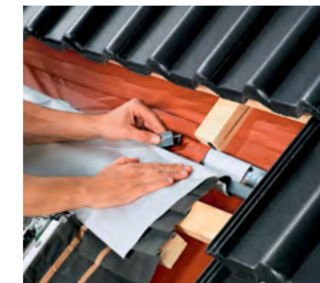
Montaż rynienki do odprowadzenia wody
