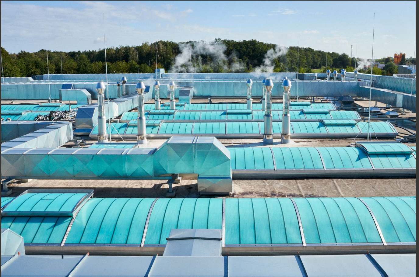
Schäfer's Backwarenfabrik, Deutschland, GRILLODUR®, gewölbte Lichtbänder mit Rauch- und Wärmeabzug
