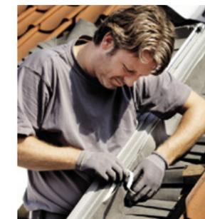
Einsetzen des neuen Fensterstocks und wetterfeste Einbindung mittels Unterdachschürze.
