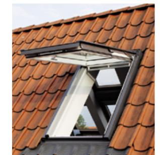
Montage des neuen Eindeckrahmens und Einhängen des neuen Fensterflügels. Fertig!
