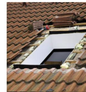
Ausbau des alten Fensters. Die Innenverkleidung bleibt unbeschädigt erhalten.
