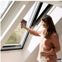
Pour nettoyer la vitre extérieure de l'intérieur, faites pivoter manuellement le châssis et fixez-le en position de nettoyage à l'aide des loqueteaux latéraux.
