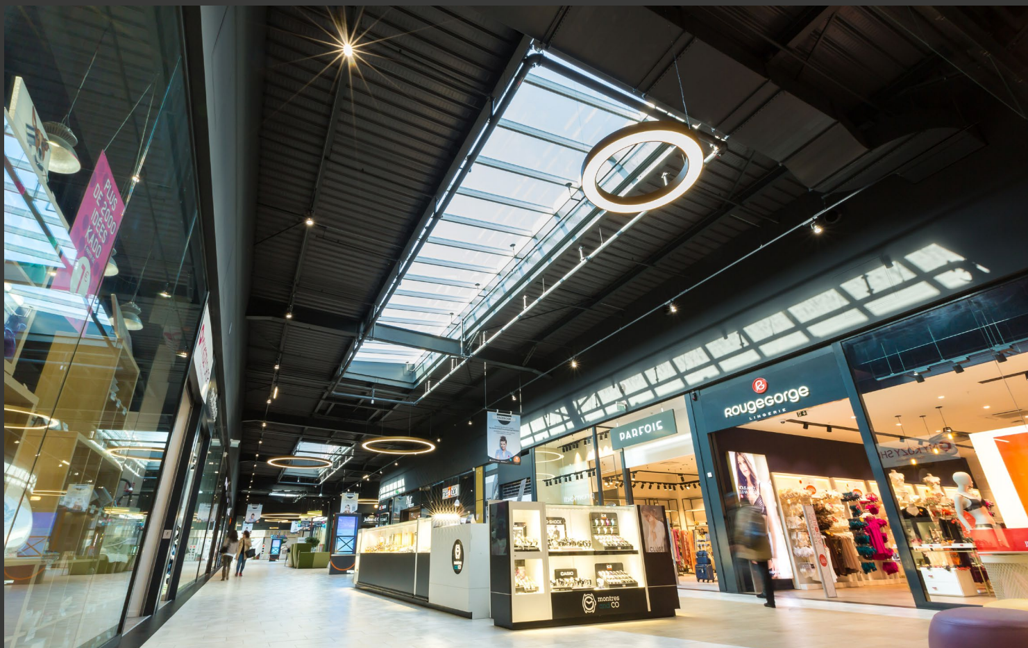
Villebon 2 Winkelcentrum, Villebon-sur-Yvette, Frankrijk. Zeven rijen lessenaarsdaken en tien rijen zadeldaken, 194 modules.
