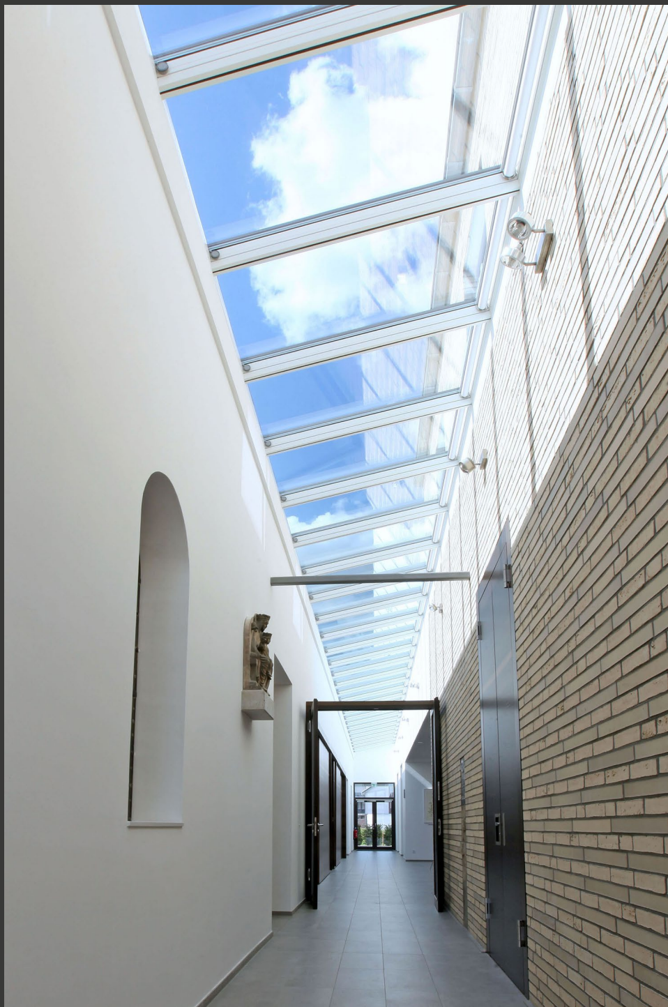
Kerk, Erkelenz, Duitsland. Lessenaarsdak met muuraansluiting, 30 modules.
