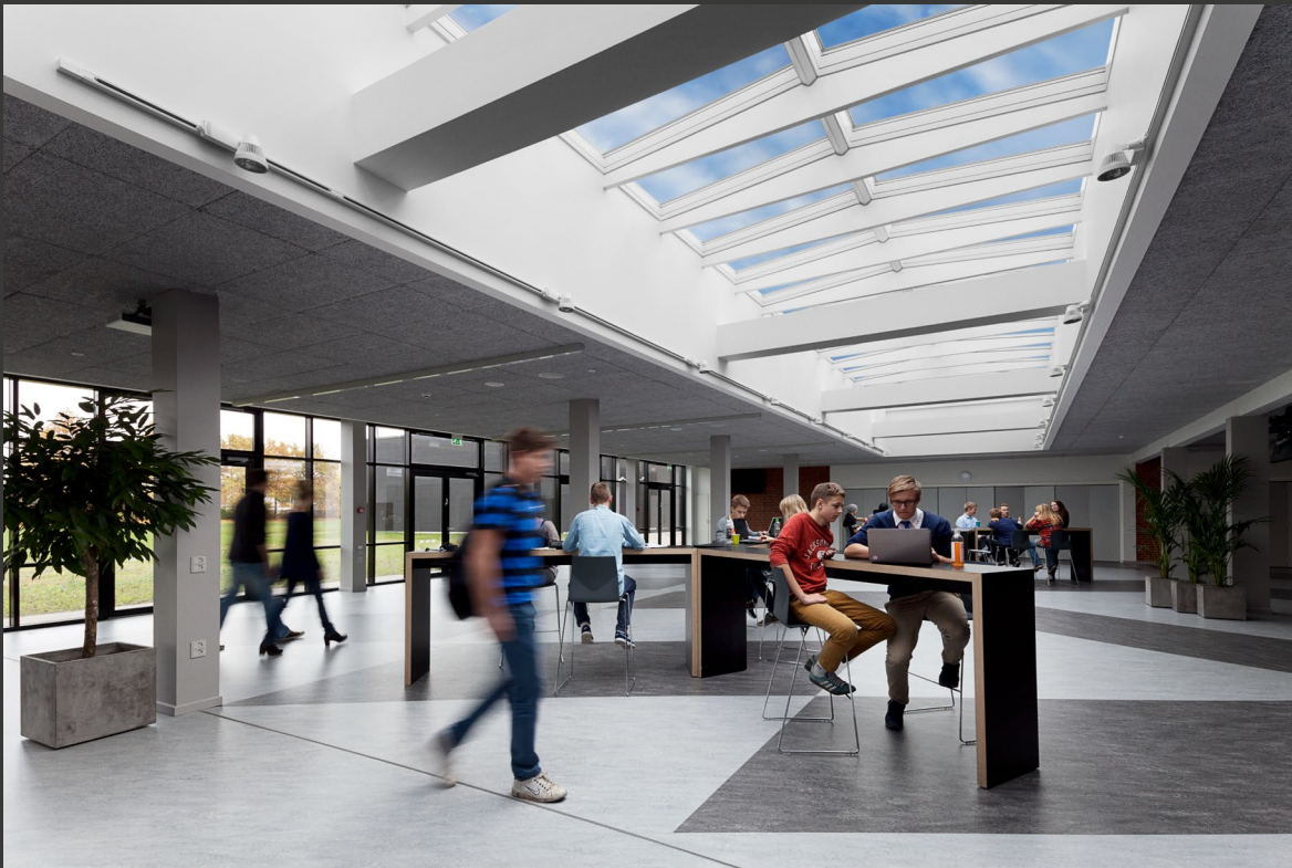
Roskilde kathedraalschool, Roskilde, Denemarken. Twee zadeldakopstellingen 5° met ondersteunende liggers, 50 modules.
