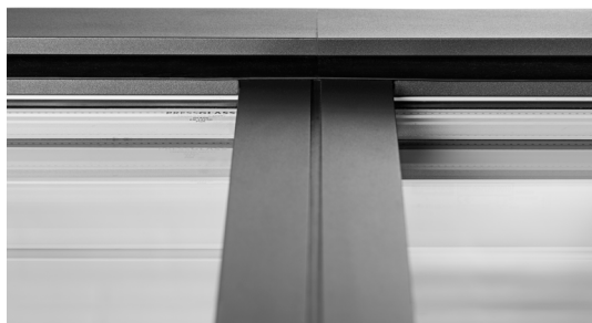
Revêtements des parties médianes et supérieures. Lanterneau 5 – 30°.
