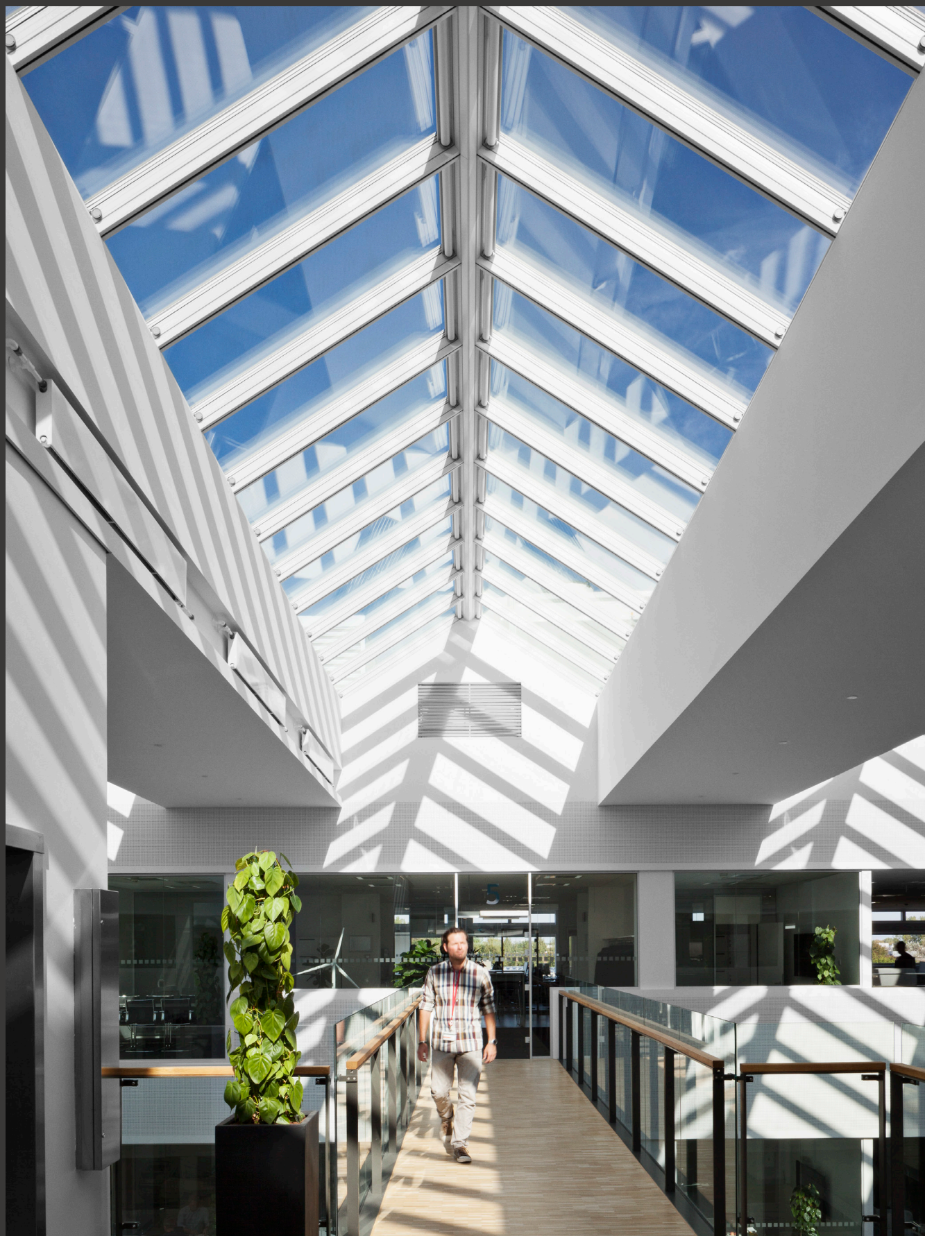
Siège de Siemens, Ballerup, Danemark. Un lanterneau à 2 pans, 228 modules.
