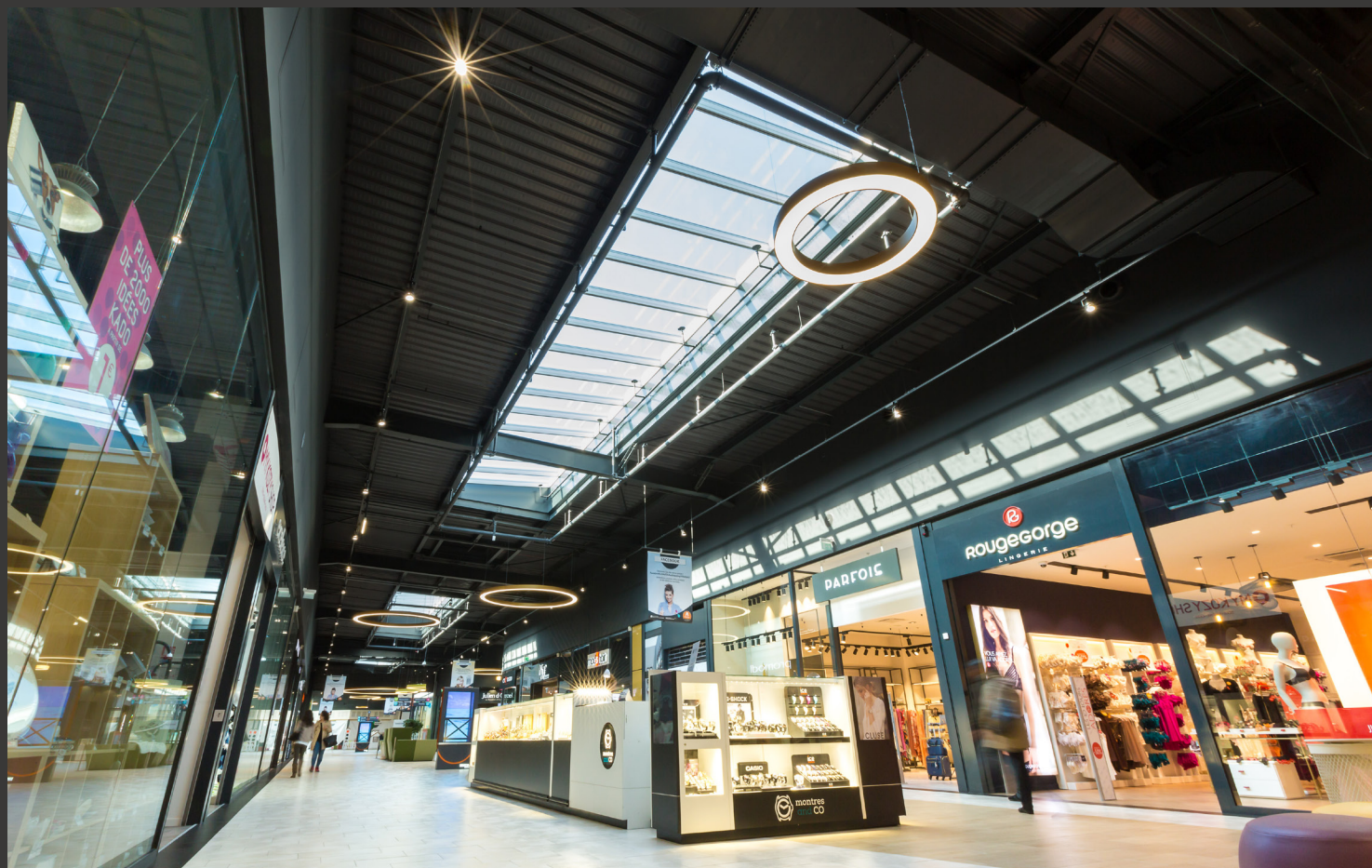
Centre Commercial Villebon 2, Villebon-sur-Yvette, France. Sept lanternes et dix lanternes à deux pans, 194 modules.
