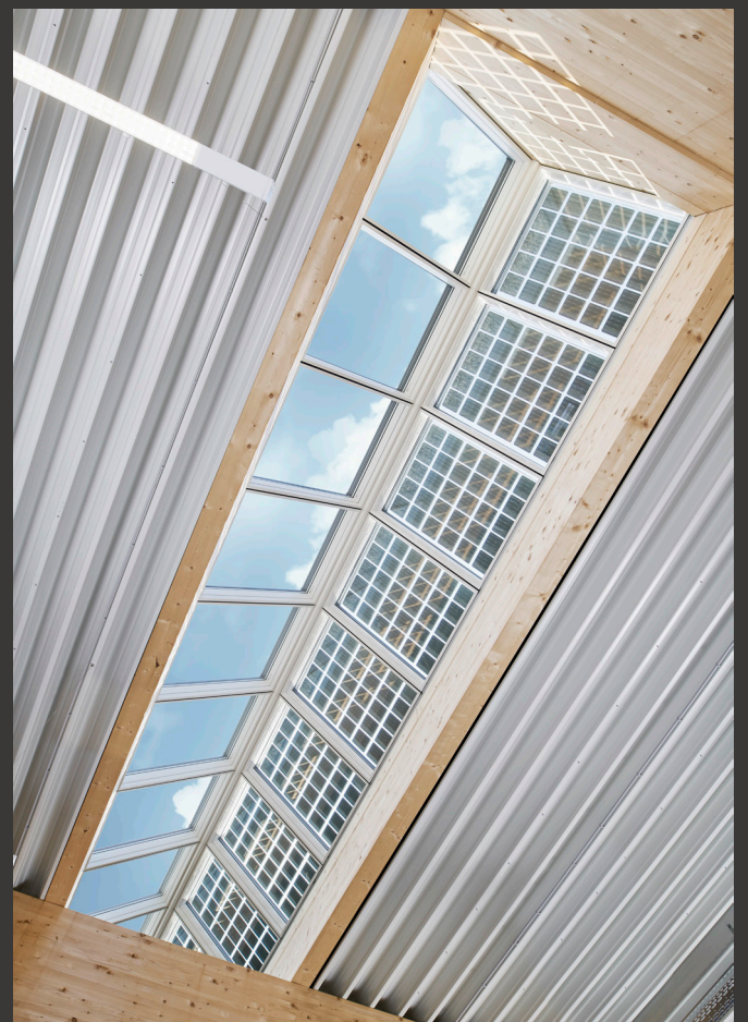
Raiffeisen, Kufstein, Autriche. Deux lanternes à 2 pans, 92 modules avec vitrage photovoltaïque
