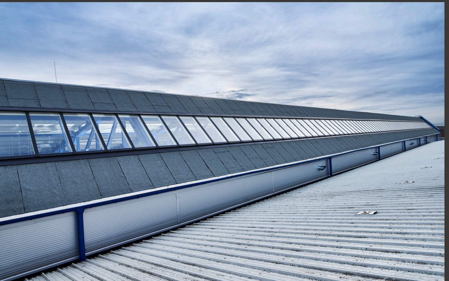
Hall d'usine GST, Sierndorf, Autriche. Un shed, 84 modules.
