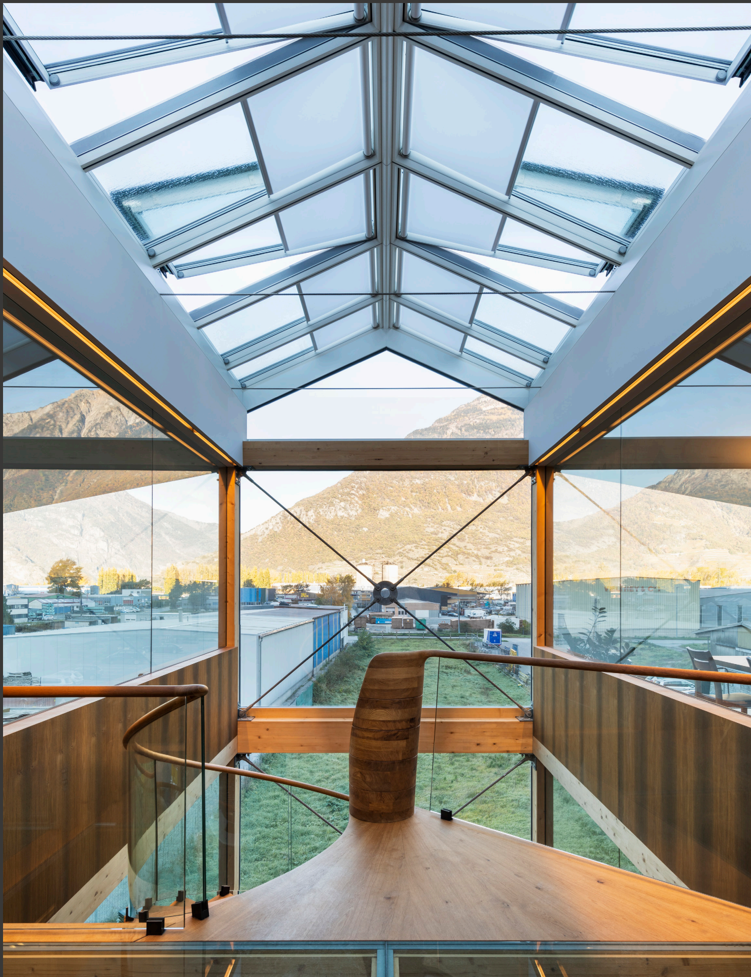
Eskiss Showroom, Martigny, Suisse. Un lanterneau à 2 pans, 12 modules avec stores intérieurs..
