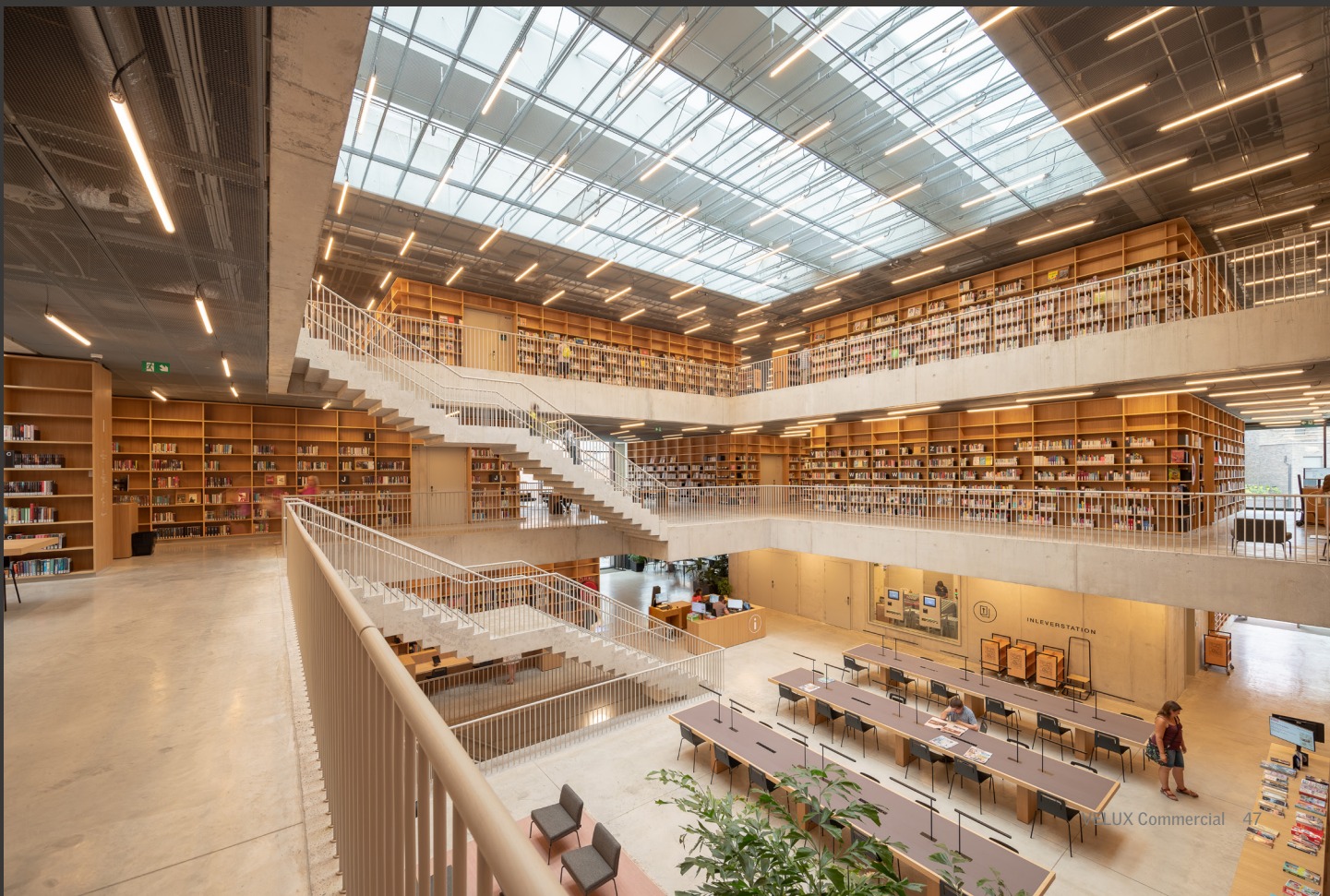
Bibliothèque Utopia, Aalst, Belgique. Un atrium, 64 modules.
