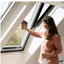
Um die Außenscheibe von innen zu reinigen, drehen Sie den Flügel und sichern Sie ihn mit den Putzriegeln in der Reinigungsposition. Das feststehende mittlere Fenster kann von außen durch Öffnen des rechten oder linken Fensters gereinigt werden.
