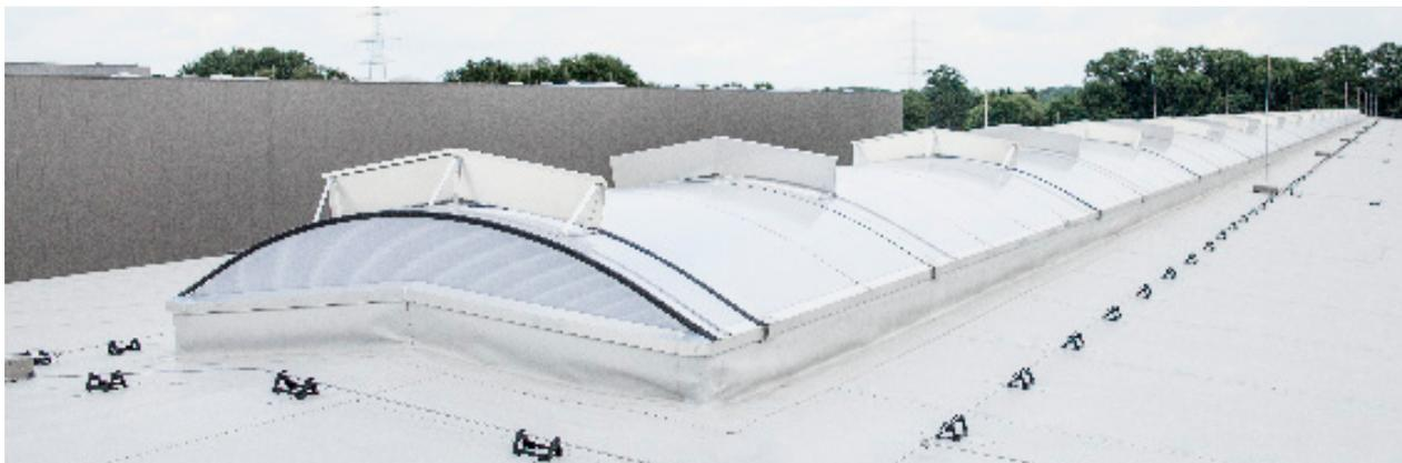
Système de profilés à rupture thermique pour la performance énergétique, avec Evaluation Technique Européenne (ETA)
