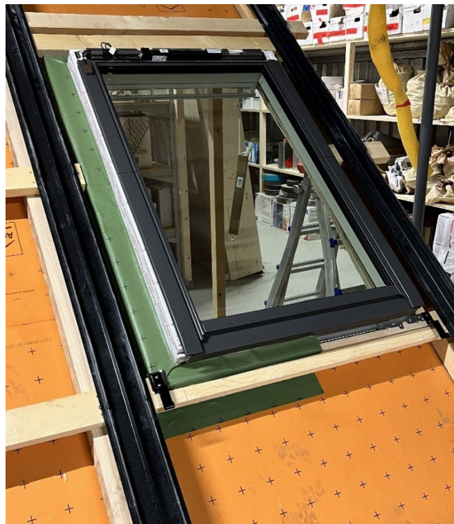
Fertig eingebautes Dachfenster ohne Eindeckrahmen
