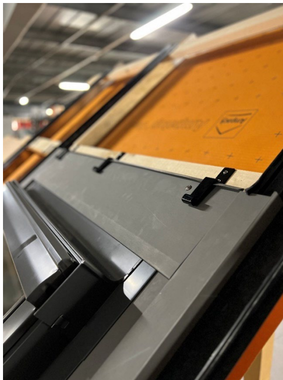
Einschubbleche seitlich und oben montiert
