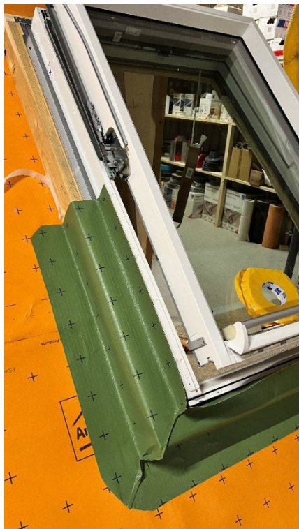
Montage mit Hilfsrahmen und Unterdachfolie
