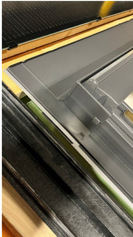
Eindeckrahmen ODG Kopfstück ohne Einschubbleche
