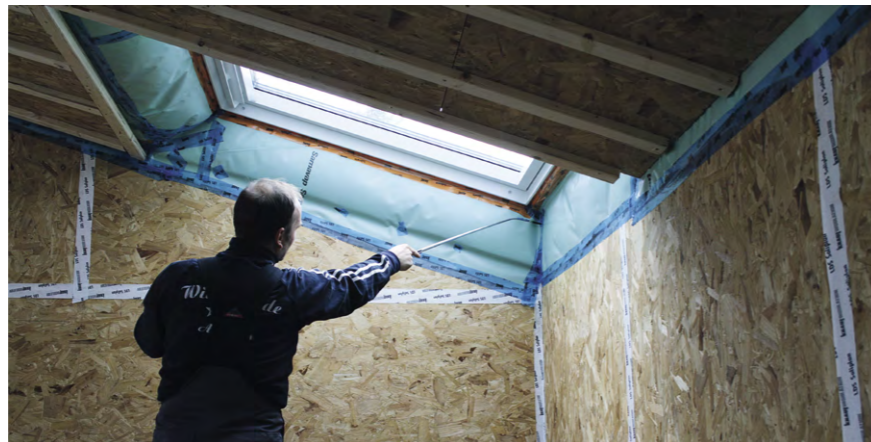
Aufspüren von Leckagen mit einem Luftgeschwindigkeitsmessgerät während der Blower-Door-Messung
