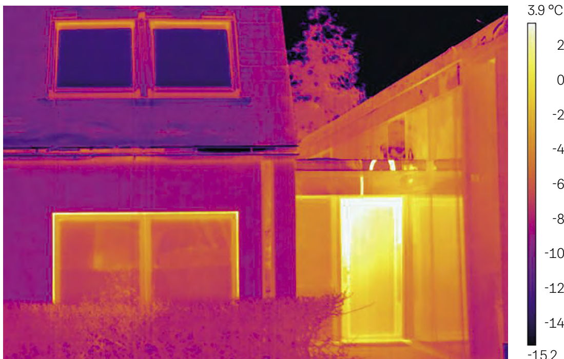
Thermografie von aussen zur Visualisierung von Wärmeverlusten
