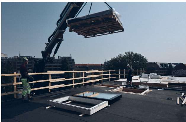
De producten het dak op takelen
