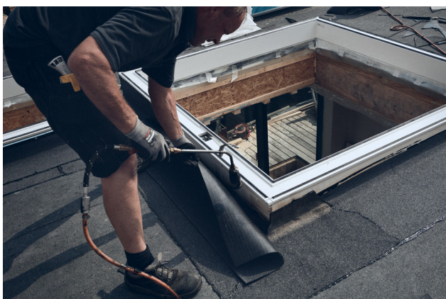
De opstand en de dakbedekking waterdicht bevestigen zonder het product bloot te stellen aan de vlam
