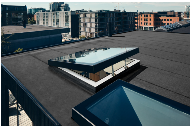
De elektriciteit aansluiten en controleren of alles werkt
