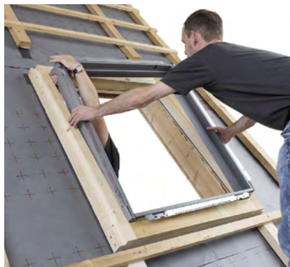
Standard-Einbau mit BDX und Holzstapelrahmen
