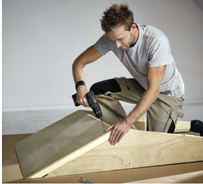
1. Die im Lieferumfang enthaltenen Dämmteile montieren.
