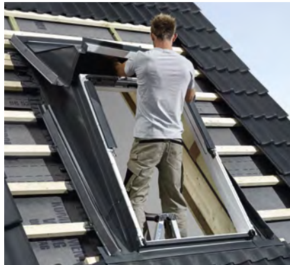
5. Anschließend die Außenverblechung anbringen und den Fensterflügel einsetzen.
