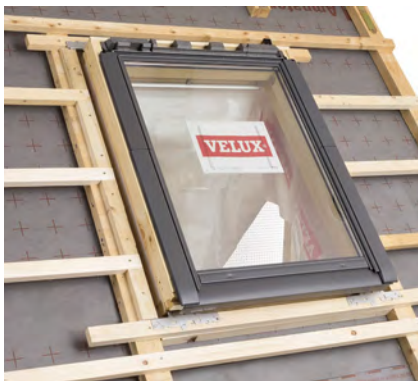
Profi Set Plus Einbau: Vor der Montage der Unterdachschürze BFX
