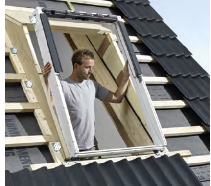
3. Fensterstock in die Dämmung einsetzen und verschrauben.
