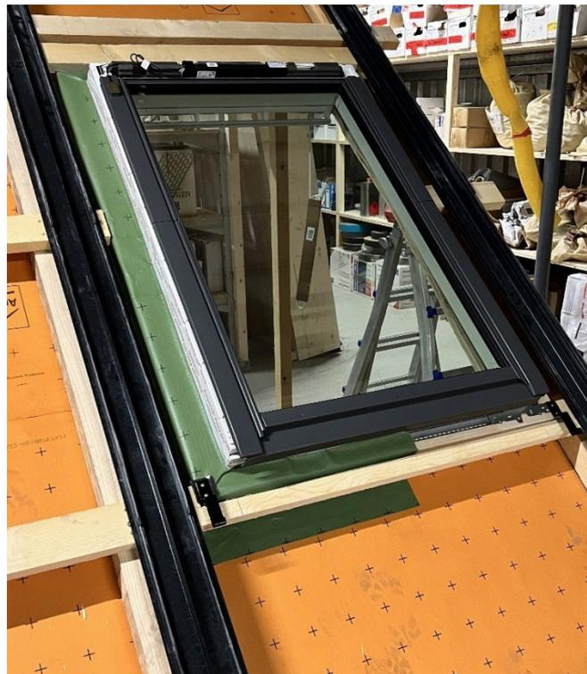
Lucernario preassemblato senza telaio di montaggio
