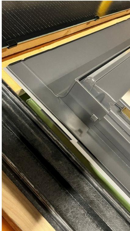
Telaio di montaggio ODL
