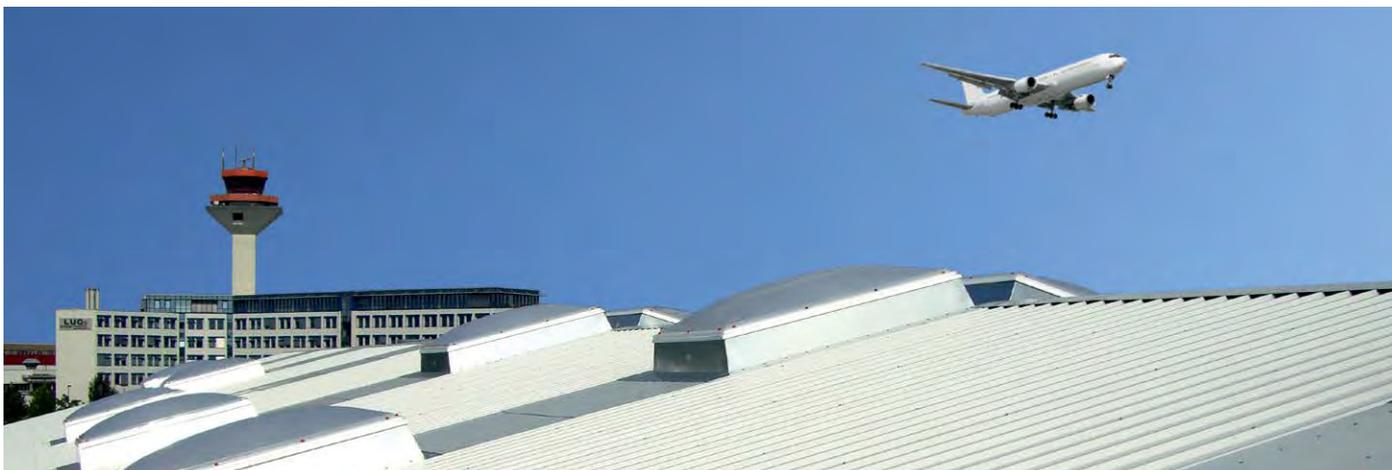
Schallgedämmte Lichtkuppel, die schützt und Tageslicht fördert
