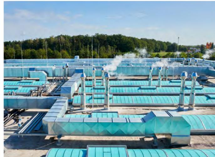
Entsprechend ausgestattete Polycarbonat-Tageslichtlösungen sind – auch aufgrund ihres geringen Gewichts – eine attraktive Option, da die bestehende Dachkonstruktion die Lasten sicher tragen kann.
