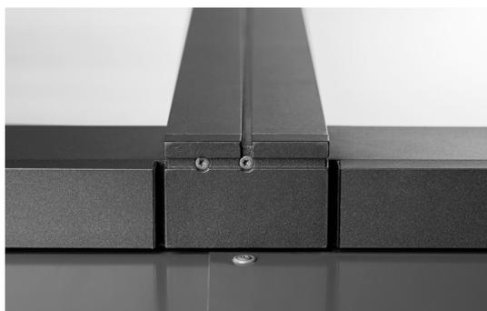
Assemblage des profilés et du raccord en bas de la verrière.
