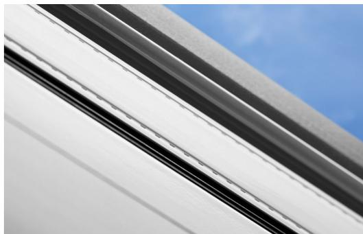
Raccordement entre le profilé intérieur, le vitrage et le profilé extérieur.
