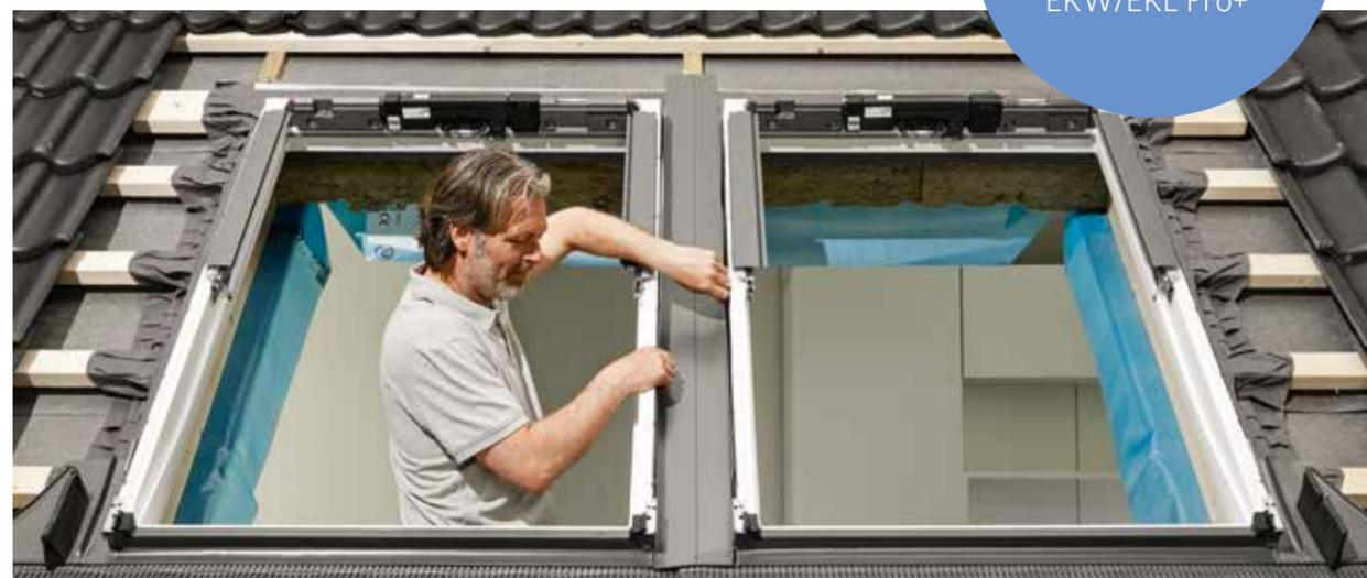
Dans le kit de raccordement Combi Pro+, vous trouverez une isolation sur mesure et facile à installer, ainsi que des colerettes étanches. Ces composants réduisent les pertes de chaleur et les ponts thermiques et offrent une sécurité supplémentaire contre la pénétration de l'eau.
