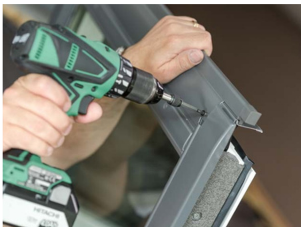
Repositionner le profilé bas et le visser de chaque côté à l'aide des vis 10 mm.
