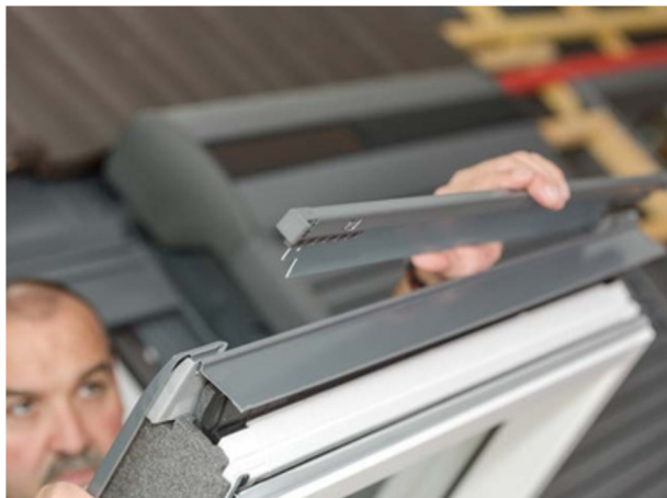
Positionner le profilé sur la partie basse de la fenêtre.
