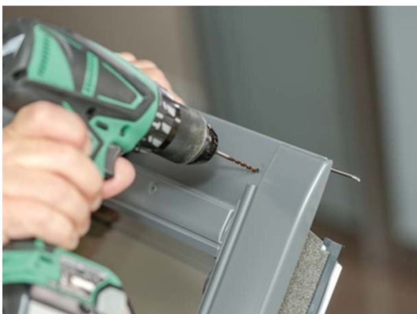
Retirer le profilé bas et percer au niveau des repères.
