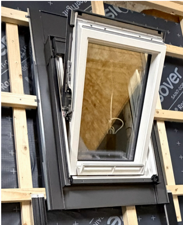
Fertig montierter ODL Eindeckrahmen für Standardeinbauhöhe.
