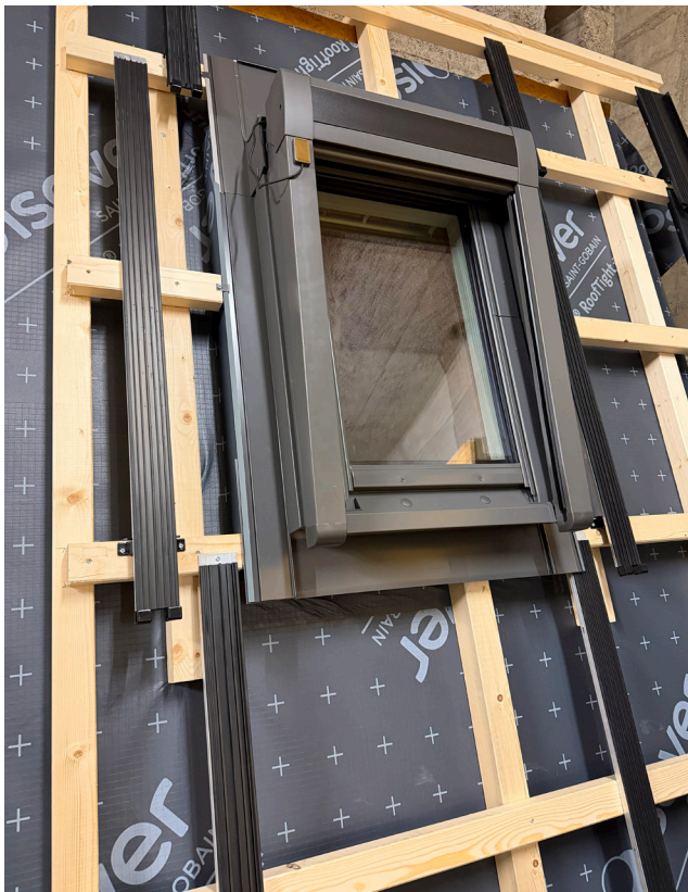
Montage der LEVEL up Unterkonstruktion (Haken und Schienen)
