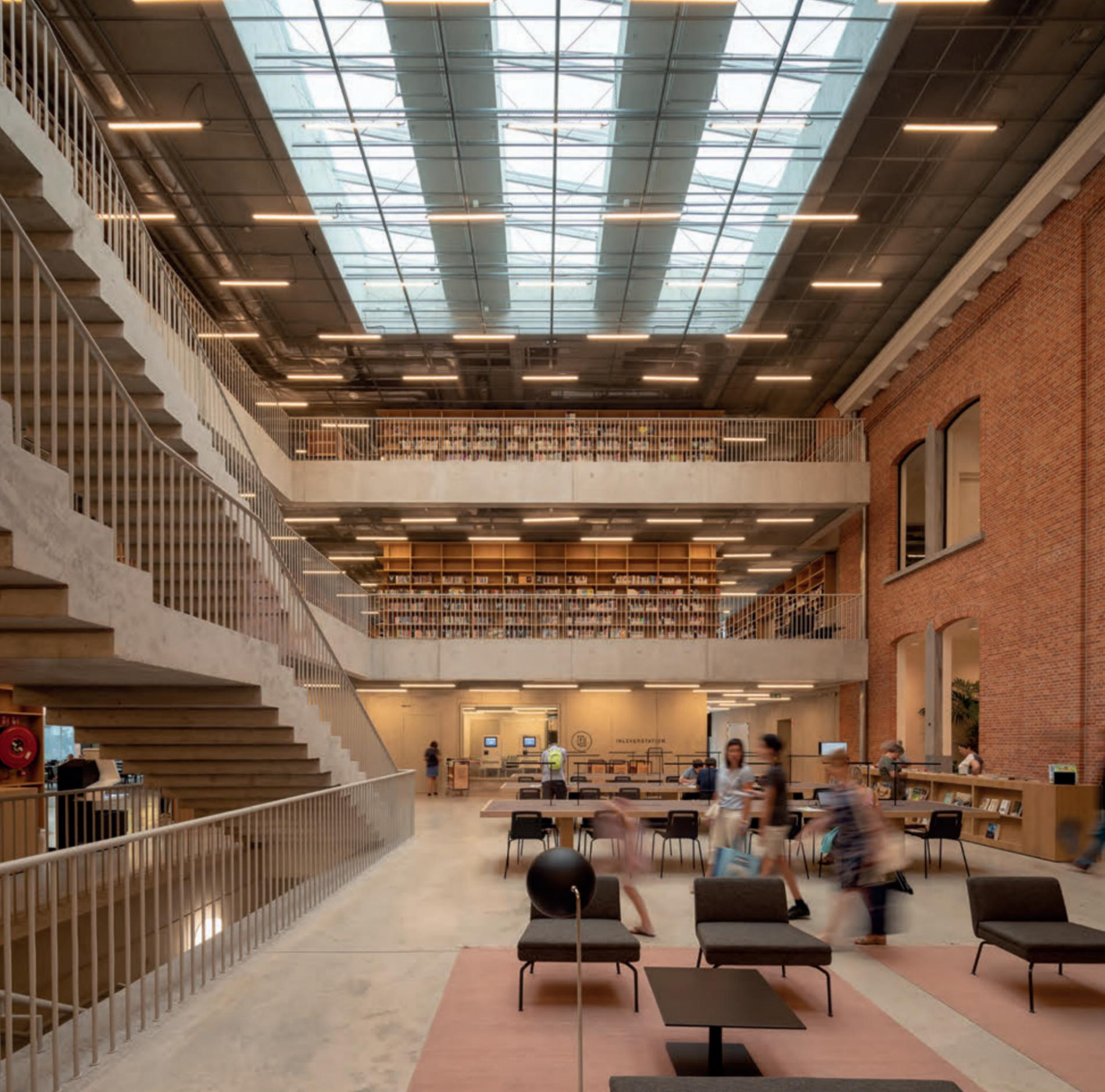
Die Deckenflächen wurden so weit reduziert, dass sie kaum noch wahrnehmbar sind. Alle technischen Systeme sind hinter einem gestreckten metallfarbenen Netz verborgen, das das kräftige Tageslicht weicher macht und tagsüber für eine angenehme Atmosphäre sorgt.
