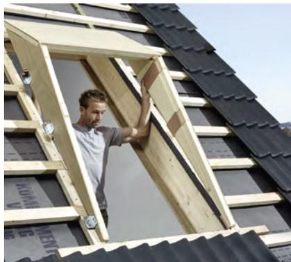
2. Applicare le parti isolanti sull'apertura allestita nel tetto e collegare con la sottostruttura.
