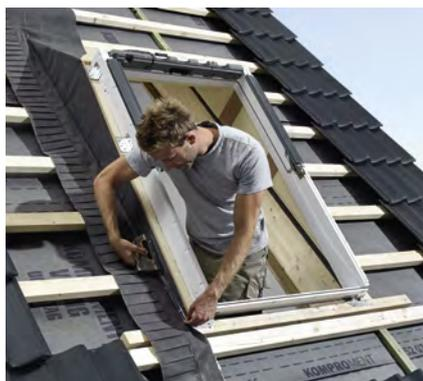
4. Per il collegamento a prova di pioggia montare la mantella d'allacciamento BFX in dotazione.
