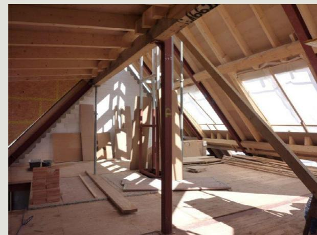
Eine Mischkonstruktion aus Holz- und Stahlbau
