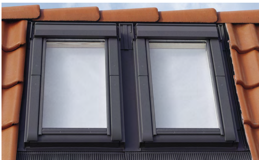
Einbau mit durchgehenden Firstziegel
