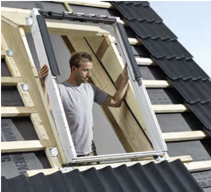
3. Insérer le cadre applique de la fenêtre dans l'isolation et visser.
