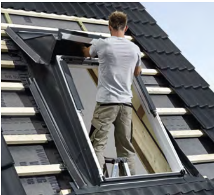
5. Poser ensuite les profilés extérieurs et mettre en place le vantail.
