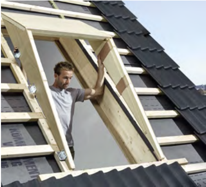
2. Poser les éléments isolants sur la découpe du toit préparée et les relier à la sous-construction.
