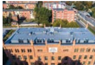
Renowacja budynku biurowego
