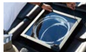
Montaż od strony dachu zapewnia wyjmowane skrzydło.
