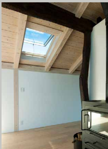
Samostatné osazení mezi krokve.
