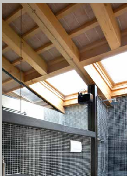
Výměna umožňuje použít střešní okno větší velikosti.
