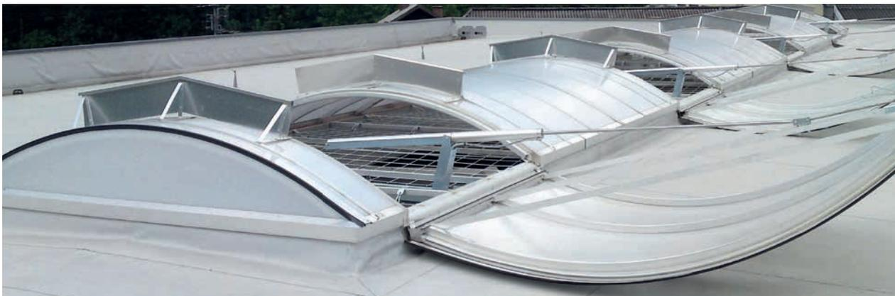
VARIO-FIREJET® 165 J AZ und VARIO-FIREJET® 165 J 24V/48V AZ sind RWA-Geräte für einen effektiven Rauch- und Wärmeabzug nach DIN EN 12101-2 mit der Funktion „Auf/Zu“
