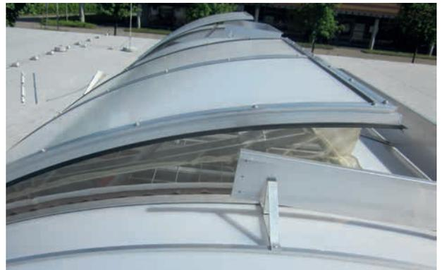
*Lichtbandklappe in Lüftungsstellung mit Insektenschutzsystem*
