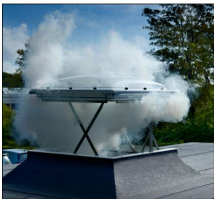
Comando elettrico con unità di comando EFC e, all'occorrenza, con tasto di ventilazione aggiuntivo.
