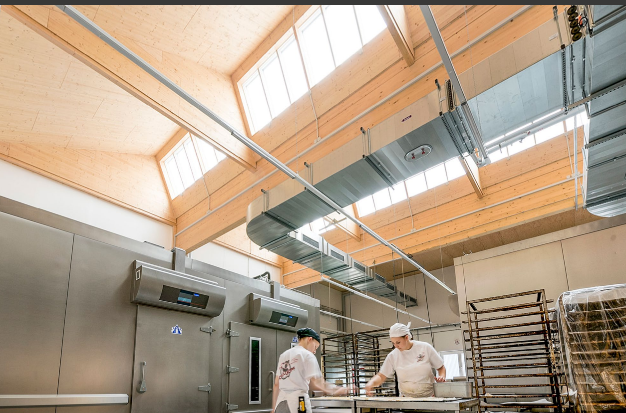
Schöllkopf Backwaren, Waiblingen, Deutschland. 3 Sheddach-Lichtbänder, 54 Module.
