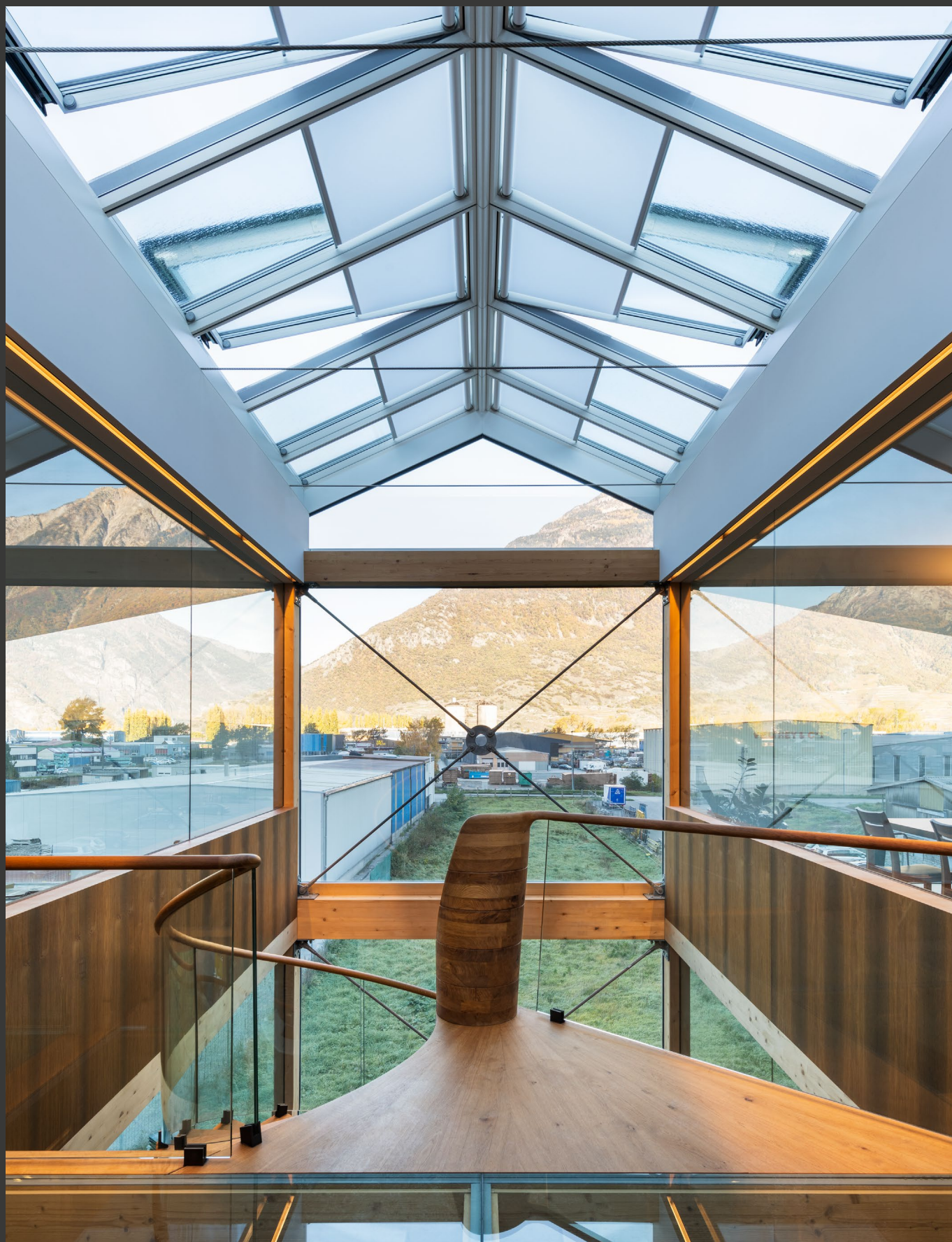
Eskiss Showroom, Martigny, Schweiz. Ein Sattel-Lichtband, 12 Module inklusive Sonnenschutz-Rollos RMM, weiss.
