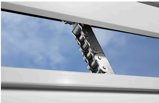
Die Kette im verborgenen Antrieb hebt das zu öffnende Modul für Komfortlüftung oder Rauchabzug.
