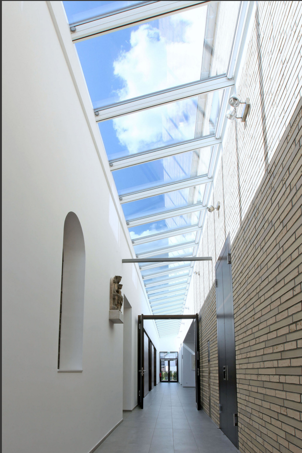
Kirche, Erkelenz, Deutschland. Wandmontage-Lichtband, 30 Module.
