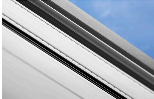
Verbindung zwischen Flügelprofil, Verglasung und Aussenabdeckung.
