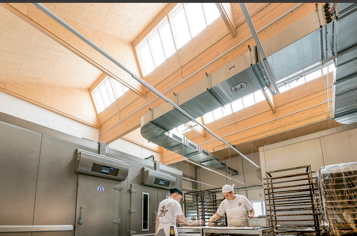
Schöllkopf Backwaren, Waiblingen, Deutschland. 3 Sheddach-Lichtbänder, 54 Module.
