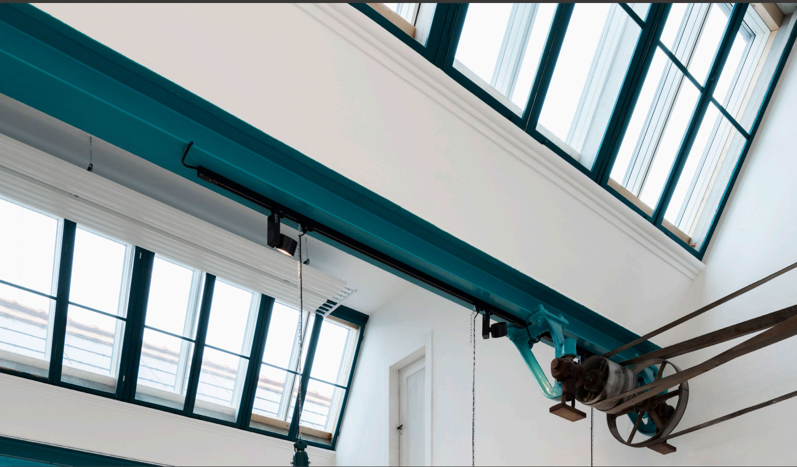
Bucher Areal, Burgdorf, Schweiz. 5 Sheddach-Lichtbänder, 160 Module
