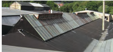
Pasma świetlne ze szkła zbrojonego przed modernizacją
