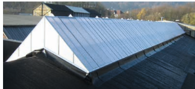
Dwuspadowe pasmo świetlne po modernizacji
