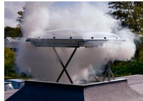
Uno degli elementi che compongono la soluzione può essere un evacuatore di fumo e calore. Possono essere inserite anche finestre per l'accesso al tetto, finestre fisse o finestre elettriche.
