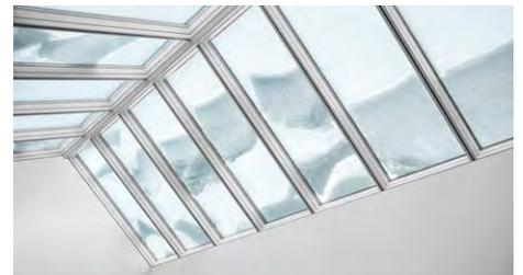
Niedrigenergieverglasung sorgt in Verbindung mit Profilen mit geringer Wärmeleitfähigkeit für einen überzeugenden Wärmeschutz.
