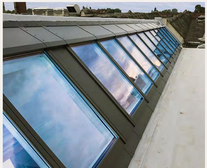
Für VELUX Modular Skylights-Systeme sind farblich passende Blindpaneele verfügbar, welche für die Abdeckung von Zwischenwänden oder auch zur Durchführung von Leitungen (z. B. für Entlüftungssysteme) auf das Dach verwendet werden.
