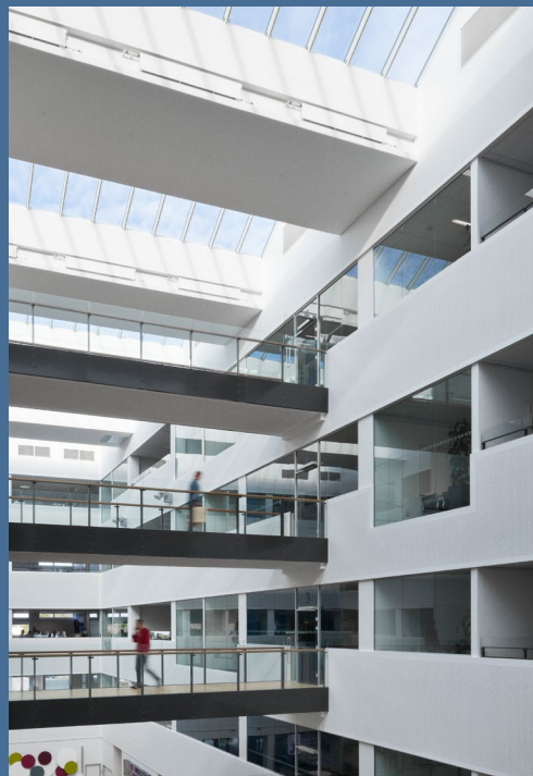
Hauptquartier, Ballerup, Dänemark, LEED Gold
