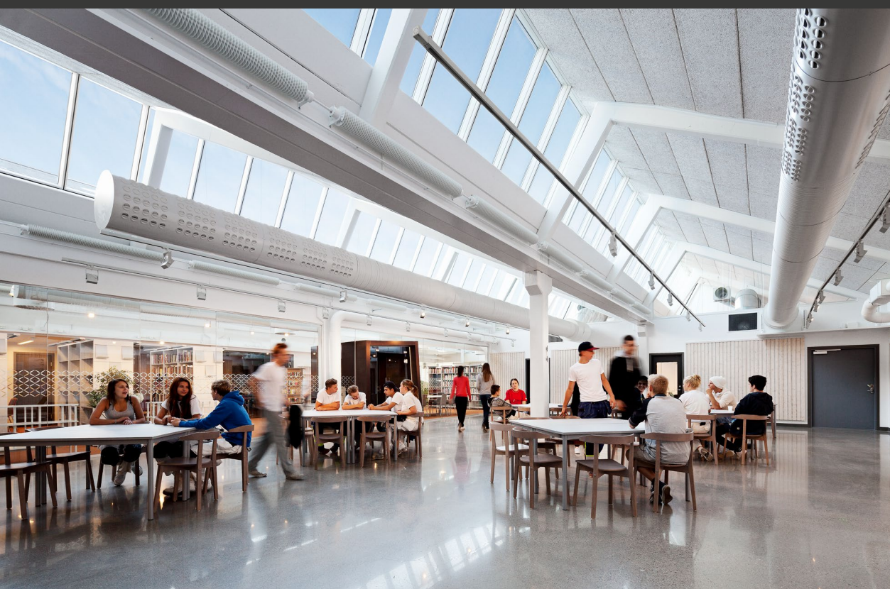
Sågbäcksgymnasiet, Stockholm, Schweden. Vier Sheddach-Lichtbänder, 104 Module.
