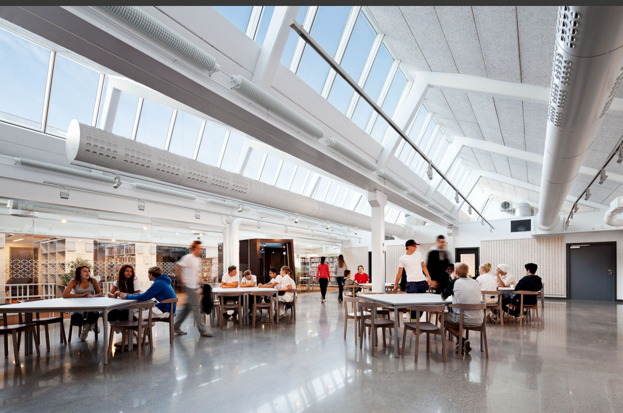
Sågbäcksgymnasiet, Stockholm, Schweden. Vier Sheddach-Lichtbänder, 104 Module.
