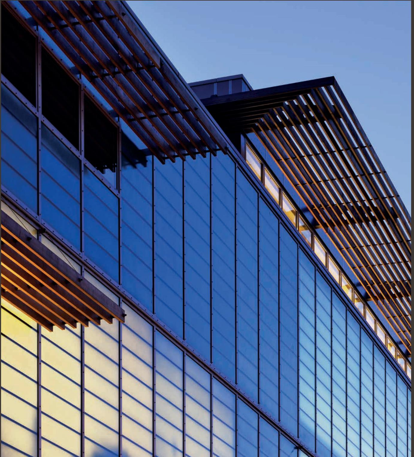
Als sinnvolle und robuste Alternative zu Glaskonstruktionen bieten sich Lichtfassaden aus GRILLODUR® an. Sie zeichnen sich durch hohe mechanische Belastbarkeit aus und sind beispielsweise absolut ballwurfsicher bis hin zur
