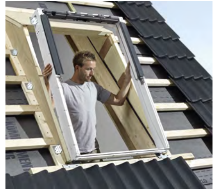
3. Fenster-Blendrahmen in die Dämmung einsetzen und verschrauben.
